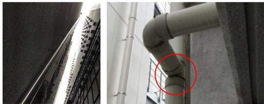
【写真】建物を見上げると水がしたり落ちていました。その場所を確認すると雨樋（縦管）の接合部が割れ隙間ができていました。
