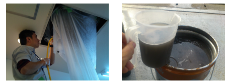
【写真】カバー、パーツ類を外すと、右上の状態になります。洗浄後の汚水を見ると右下のような状態でした。
